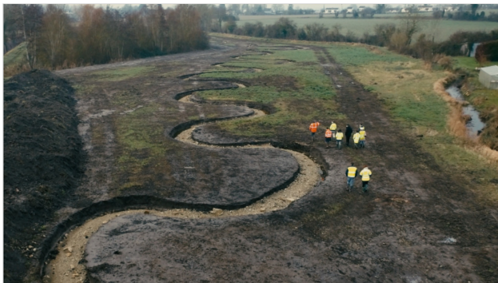
Légende : Lit terrassé du ruisseau de Marcé. SMBVAR
