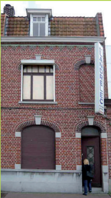
Vue d'une façade restaurée sur rue
