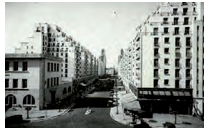
Le quartier des Gratte-Ciel à Villeurbanne, en 1934.
