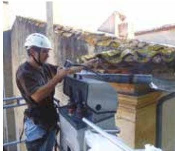
Inspection d'interstice avec un fibroscope (caméra endoscopique).
