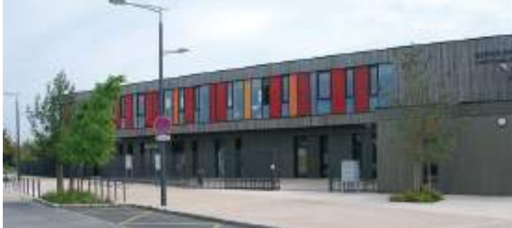
ÉcoQuartier du Hameau, Saint-Jean-de-Braye, Centre-Val de Loire, Étape 3, 2016
