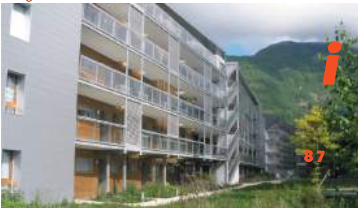
Blanche-Monier, Grenoble, Auvergne-Rhône-Alpes, Étape 3, 2014 # Logements communaux réservés
