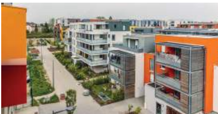
ÉcoQuartier de la Brasserie, Strasbourg, Grand Est, Étape 3, 2017
