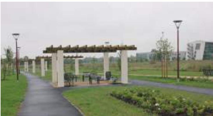
Quartier de l'Eau Vive tranche 1, Lieusaint, Île-de-France, Étape 3, 2017 # Stockage sur espace public
