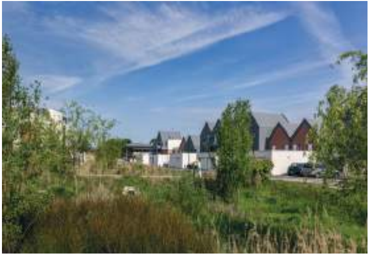
ÉcoQuartier des Arondes, Roncherolles-sur-le-Vivier, Normandie, Étape 3, 2017
