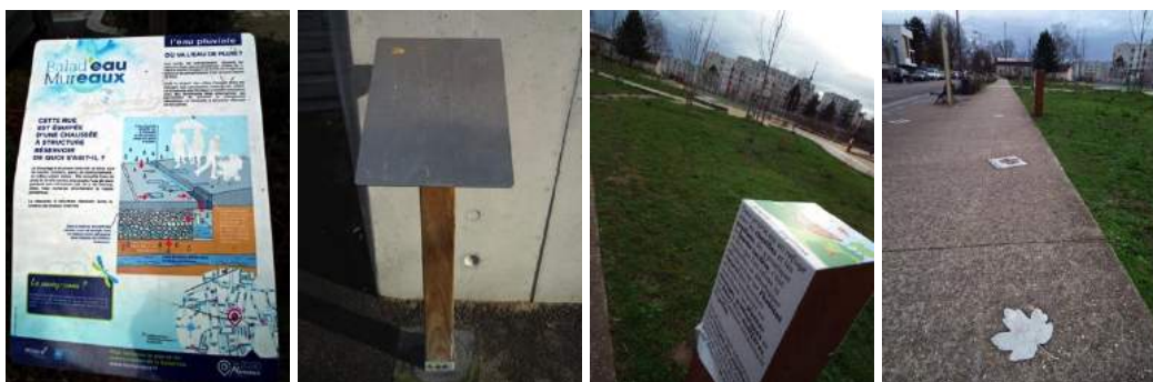
Figure 30 : ÉcoQuartier Molière : un panneau de Balad'eau Mureaux complet et un autre dégradé au pied du Pôle Molière – Signalétique Prairies à papillons et chemin des feuilles d'arbre le long de la Rue Molière (Photos : C. Hosity)
