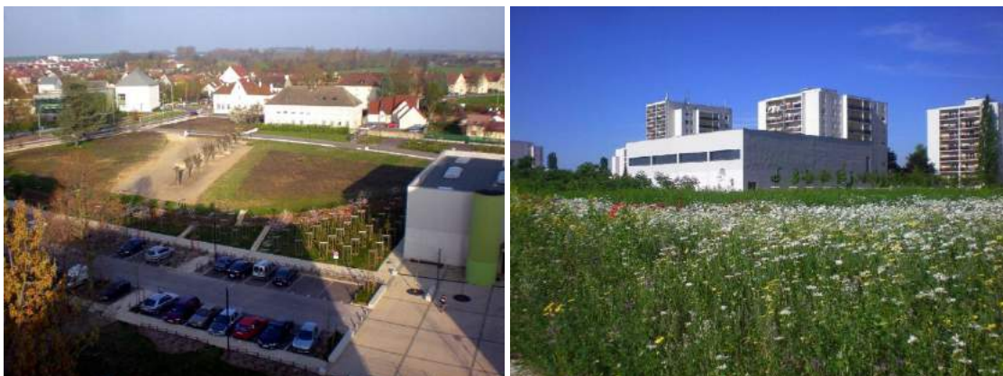
Figure 13 : Vue aérienne du site de l'ÉcoQuartier des Rives du Bief à Longvic et vue des jachères fleuries avant construction (Photos : Ville de Longvic)
