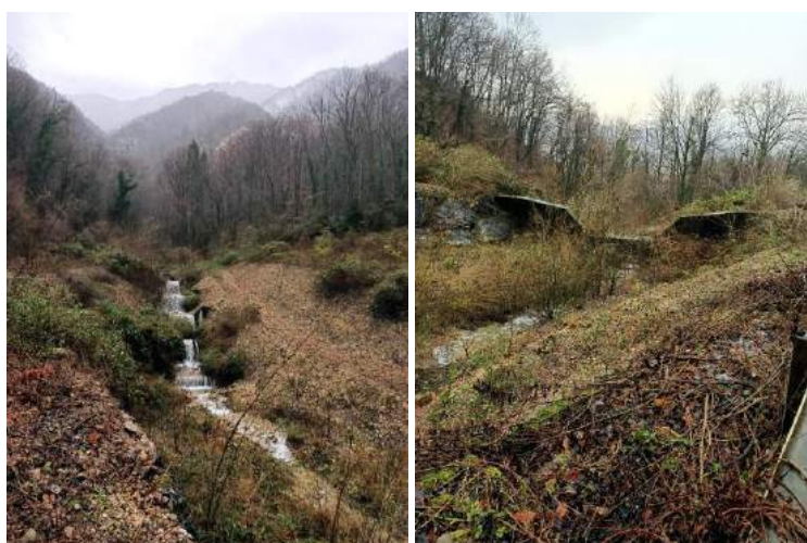
Figure 4 : Vues sur l'aménagement hydraulique du ruisseau l'Échinard en amont de l'ÉcoQuartier du Cœur de bourg à La Rivière (Photos : F. Odier)
