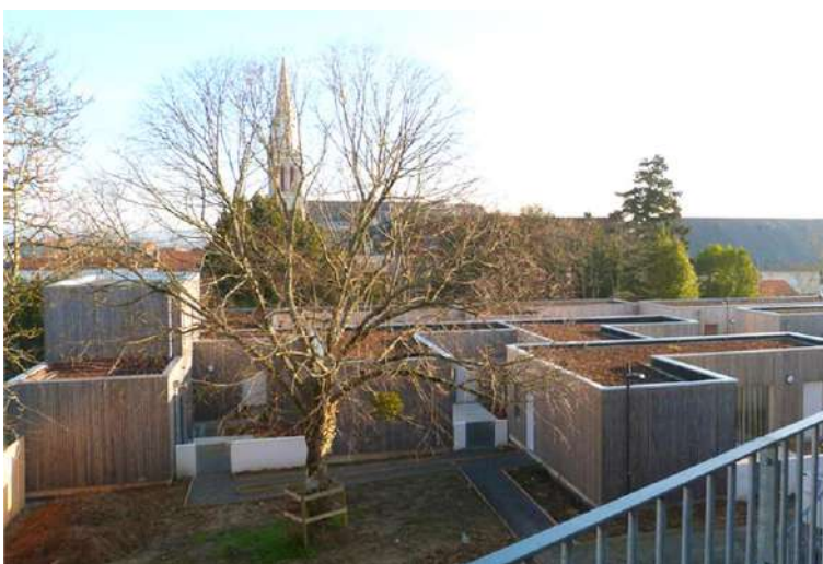
Vue sur les maisons ossatures bois
