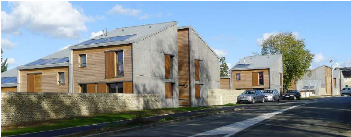
Vue d'ensemble de l'opération, qui associe différents matériaux (béton, zinc et bois). Des panneaux solaires sont intégrés à la toiture et des murs en gabion permettent l'insertion dans le paysage vexinois
