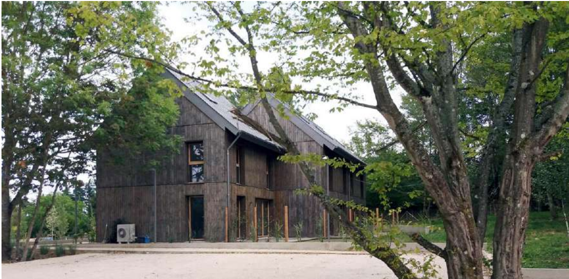
Des logements en ossature et bardage bois et des espaces extérieurs communs généreux
