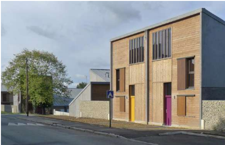
Une façade sur rue avec de grandes ouvertures favorisant l'entrée de la lumière naturelle
