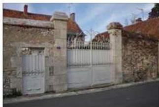
Double portail en ferronnerie ménagé entre piliers en pierre de taille calcaire surmontés de pierres pyramidales (Montlivault).
