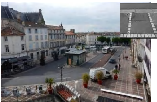
Place Bouillaud : trottoirs en enrobé et quadrillage en pavés béton
