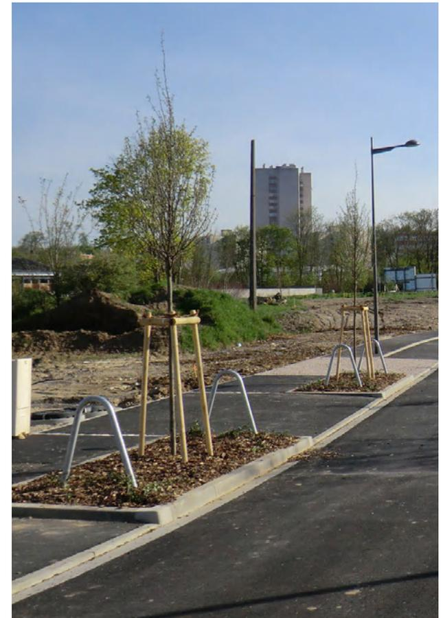
La mise en place s'effectue après résorption complet du foisonnement de la terre de remblai dans la fosse de plantation (comblement des fosses + 15 jours minimum).
