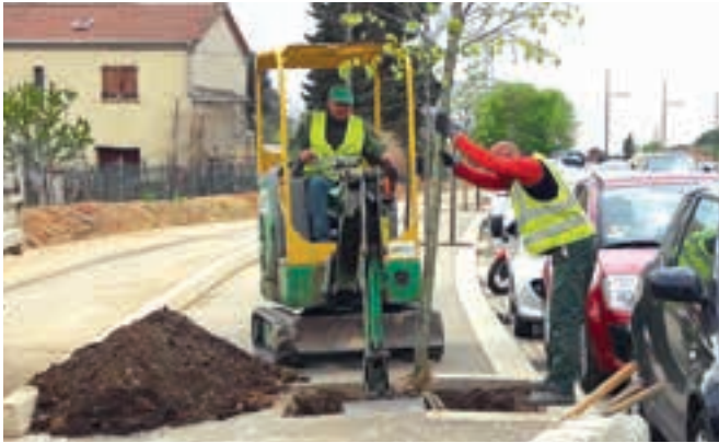
TRAVAUX DE PLANTATION, AVENUE NINA SIMONE
