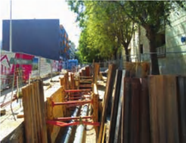
TRANCHÉES POUR RÉSEAUX, RUE DE L'ÉPIRE
