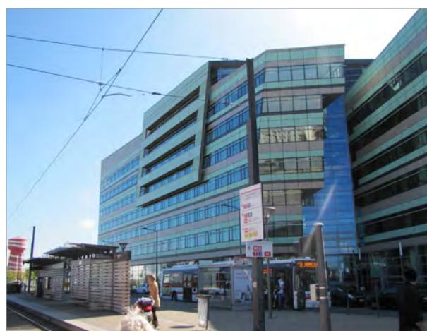
Immeuble tertiaire WOOPA - Vaulx-en-Verin Carré de Soie
