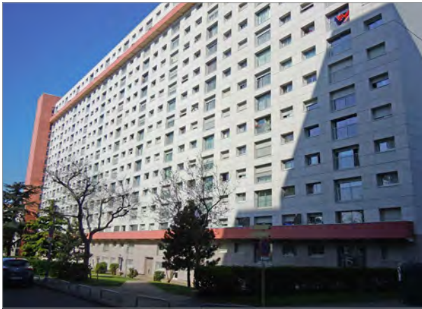
Copropriété réhabilitée - Vénissieux
