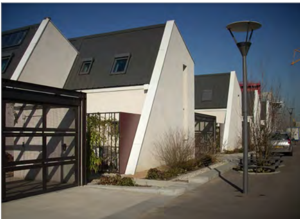
Logements de Haute Qualité Environnementale Hauts-de-Feuilly - Saint-Priest
