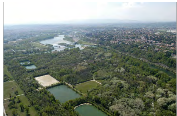
Zone de captage des eaux de Crépieux-Charmy
