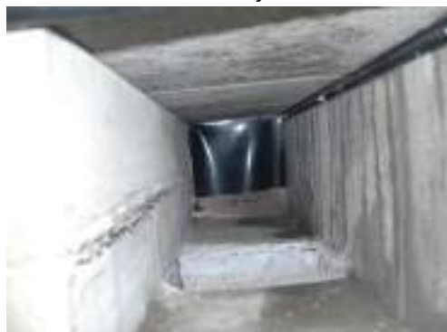
Vue intérieure du collecteur
