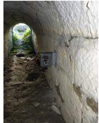
Pose dans un ouvrage
