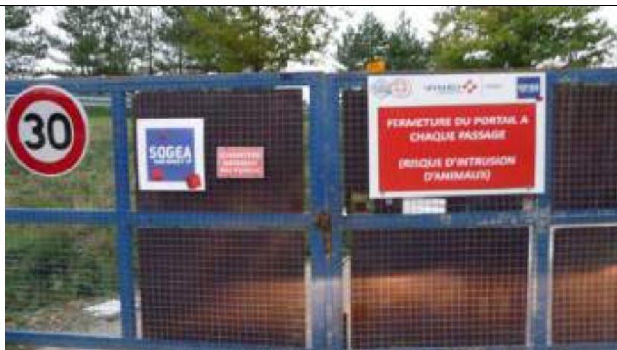
Dispositif de portail de chantier avec panneau indiquant la fermeture obligatoire à chaque passage en raison du risque de pénétration de la faune – Photo : Ecosphère
