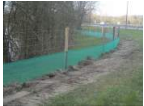
Filet anti-batraciens installé sur un grillage – Photo : internet
