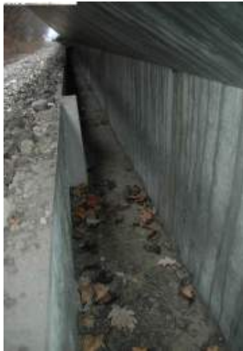
Caniveau en U avec échappatoire pour les micromammifères
