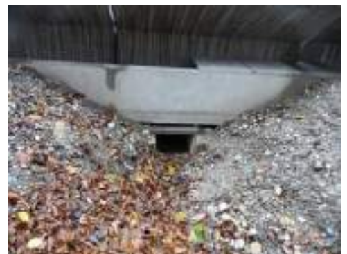
Sortie du passage sous la chaussée
