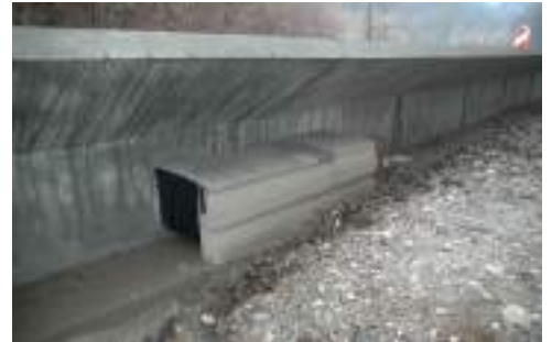
Caniveau en L avec collecteur et ses bavettes
