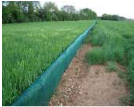
Filet anti-batraciens installé le long d'une emprise chantier – Photo : Ecosphère
