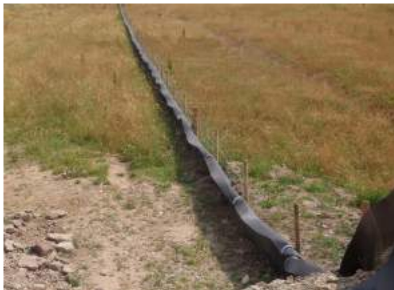
Exemple de membrane installée avec système anti-retour et tremplin de terre - Photo : Ecosphère
