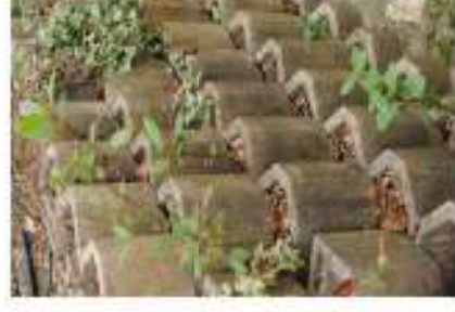
Mur de soutènement en godets végétalisés (essences diverses)
