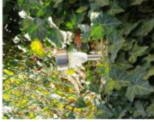
Eclairage autonome (capteur solaire) d'une montée d'escalier en jardin privé
