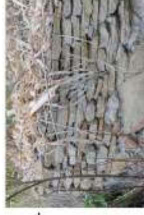
Mur de soutènement en pierres sèches non jointées
