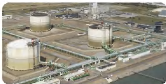
Terminal Méthanier de Montoir de Bretagne
