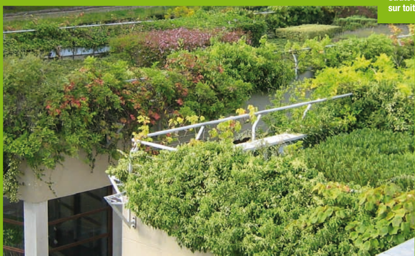
Strate arbustive sur toiture
