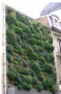
Mur modulaire monobloc Rue de la Veste - Reims © BV-Eurométropole de Strasbourg
