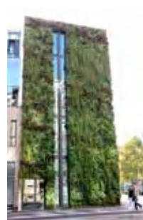
Mur modulaire monobloc de l'École Nationale d'Administration Strasbourg - © TM-SAS
