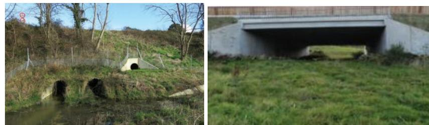
*Exemples d'écoduc en proximité d'ouvrages hydrauliques et passage inférieur à grande faune – Sources : LPO France – Vinci Autoroutes - FRAPNA Loire*
