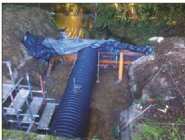
Figure 14 : A gauche : dérivation par busage et batardeaux ; à droite : pêche électrique préalable réalisée par la FDPMA (source Vinci Autoroutes)
