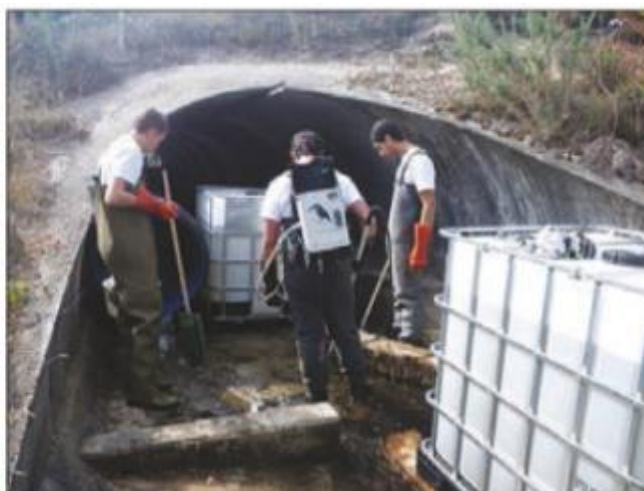
Figure 14 : A gauche : dérivation par busage et batardeaux ; à droite : pêche électrique préalable réalisée par la FDPMA (source Vinci Autoroutes)
