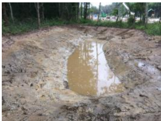
Remplissage en eau
