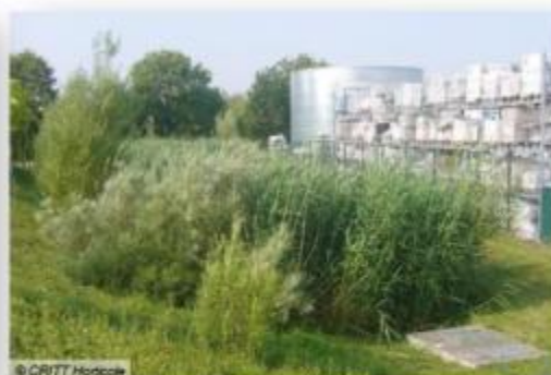
Illustration 2 – Hélophyte. Le centre de ce bassin d'infiltration est végétalisé par une roseau. Le mouvement des grandes tiges des roseaux (action du vent) ainsi que leur chevelu racinaire, créent des chemins d'infiltration préférentiels. L'activité biologique est également favorisée et entretient la porosité* du sol. Cet aménagement nécessite un entretien régulier.
