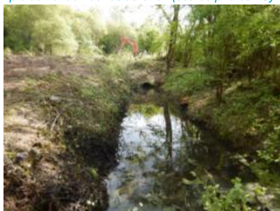
Remise à ciel ouvert : avant
