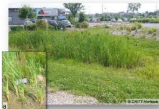
Illustration 1 – « Brosse » végétale. Ce bassin d'infiltration et de stockage est situé à l'interface de différents espaces circulés. Les différentes strates de végétaux filtrent progressivement les EP. Par exemple les graminées agissent comme une sorte de peigne et retiennent les plus gros débris (a).
