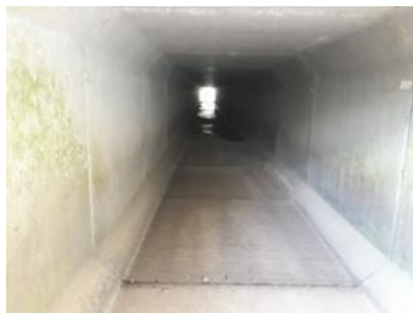
Intérieur de l'ouvrage actuel
