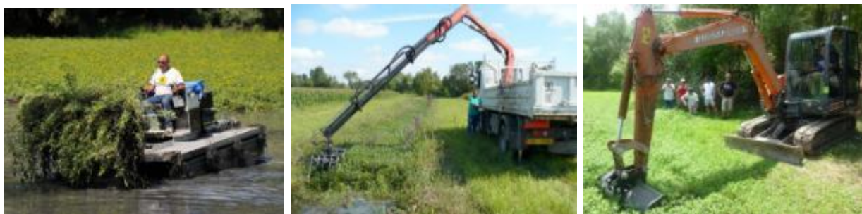
De gauche à droite : faucardage (© Energis Nautic Services), enlèvement à la griffe (© N. Pipet) et enlèvement au godet
