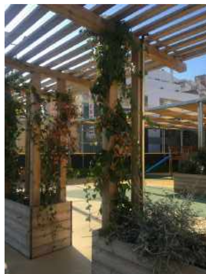
Pergola en bois avec poteaux ancrés dans les jardinières, école Dovella, Barcelone © CAUE de Paris
