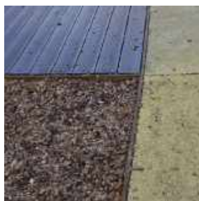
Limite entre copeaux, platelage et béton drainant avec une lisse en bois
