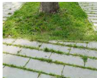
Pavés enherbés, groupe scolaire Stéphane Hessel-les Zéfirottes, Montreuil © CAUE de Paris
