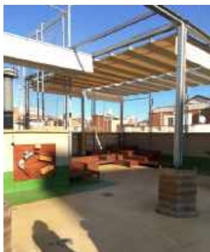
Voiles rétractables, école Dovella à Barcelone © CAUE de Paris
