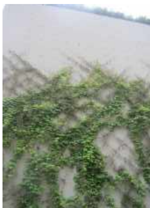
Mur végétalisé sur câbles tendus © CAUE de Paris
