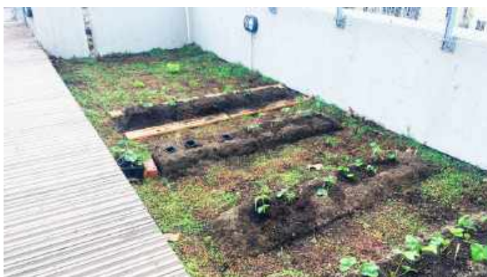
Toiture terrasse plantée, école Saint-Merri, Paris © CAUE de Paris
