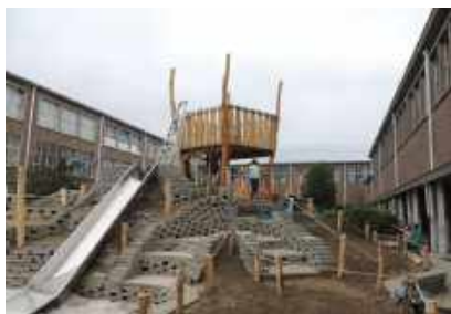
Butte constituée de dalles issues du sol École élémentaire De Piramide, Anvers © Groenman
