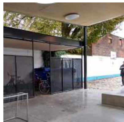
Luminaire plafonnier sous un auvent Lycée français, Anvers © CAUE de Paris
