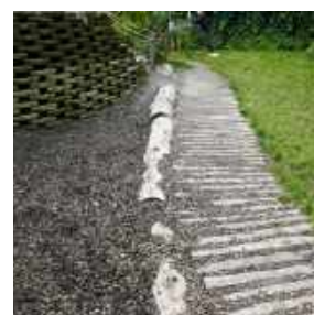
Muret en pavés entre un cheminement en bois et des copeaux
