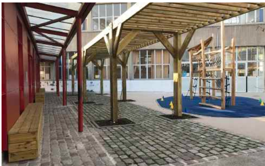
Pergola en bois avec ancrage au sol dans des fosses de pleine terre, école Emile Levassor, Paris © CAUE de Paris
