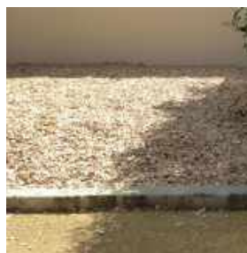
Muret en pavés entre du béton et des copeaux
