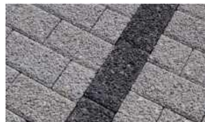
Pavés en béton coquillage drainant
