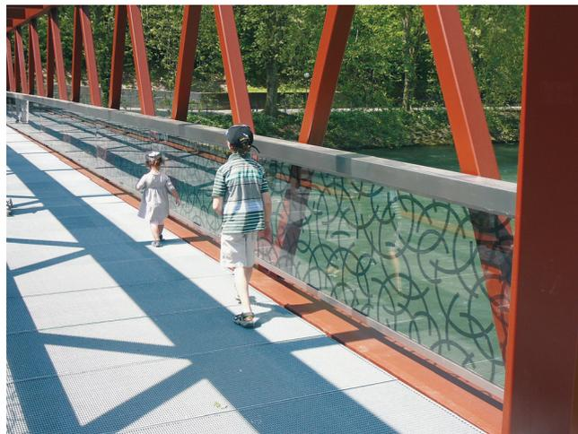
FIG. 8. — Vitres d'un pont ornées de motifs permettant d'augmenter leur visibilité. Crédit : Volgelwarte.ch / ASPAS.
