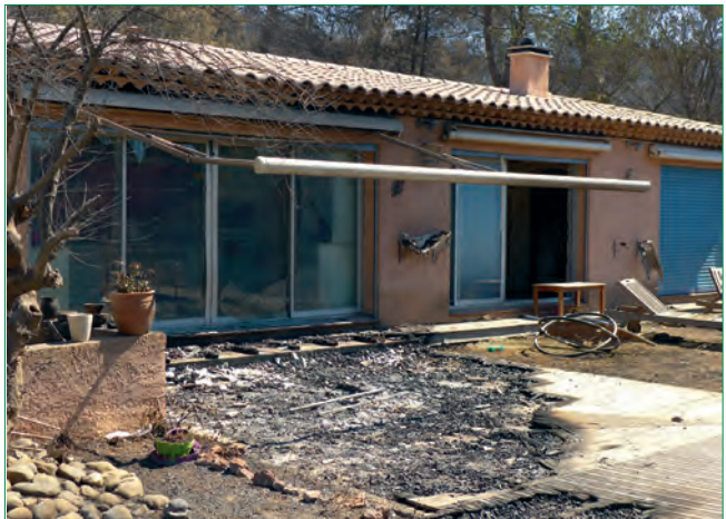
Figure 25. Vitres brisées et PVC endommagé suite à l'inflammation de la terrasse en bois (feu de Rognac, 2016)
