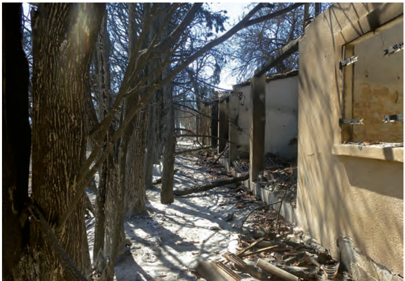
Figure 28. Bâtiment endommagé par le feu propagé par la haie de cyprès positionnée trop près (feu de Rognac, 2016)
