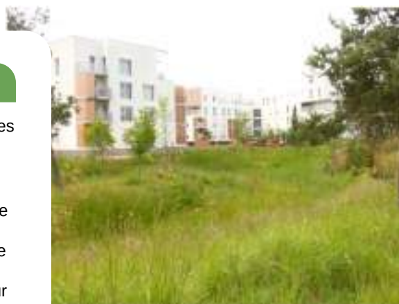
Site après les travaux
