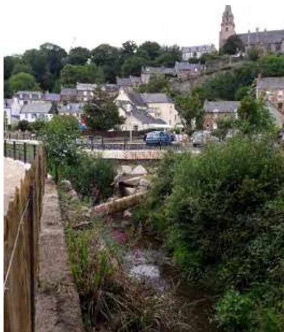
Site après les travaux
