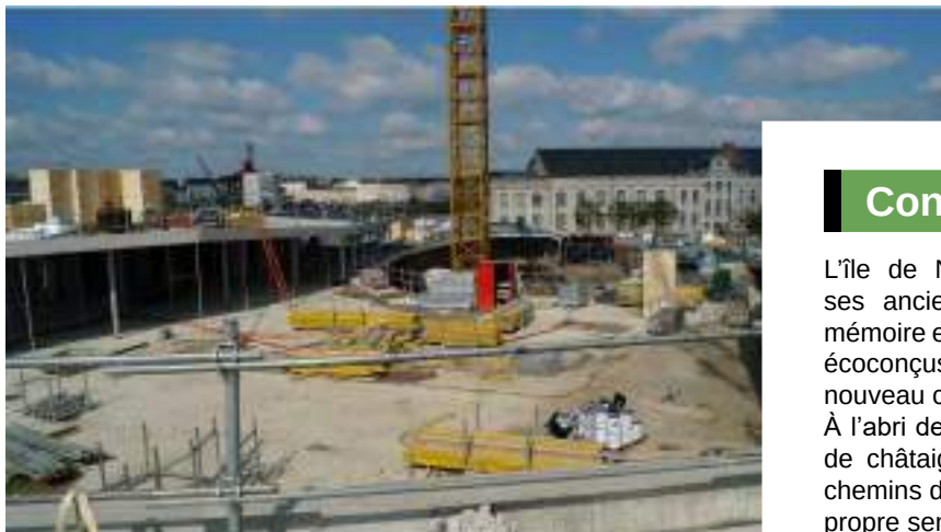
Site avant les travaux ©PHYTOLAB
