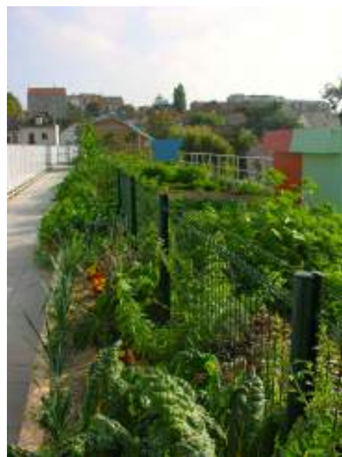
Toiture végétalisée : potager pédagogique © Ville de Rosny-sous-bois
