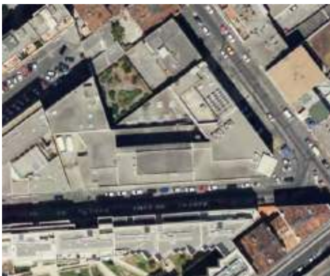
Vue aérienne du bâtiment avant réhabilitation (2019)
