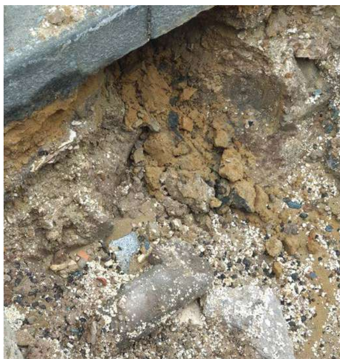
Des sols fortement modifiés sous les enrobés © Maëva Felten
