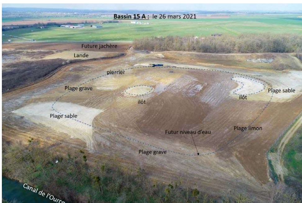
Image du site en cours de renaturation après travaux de dépollution
