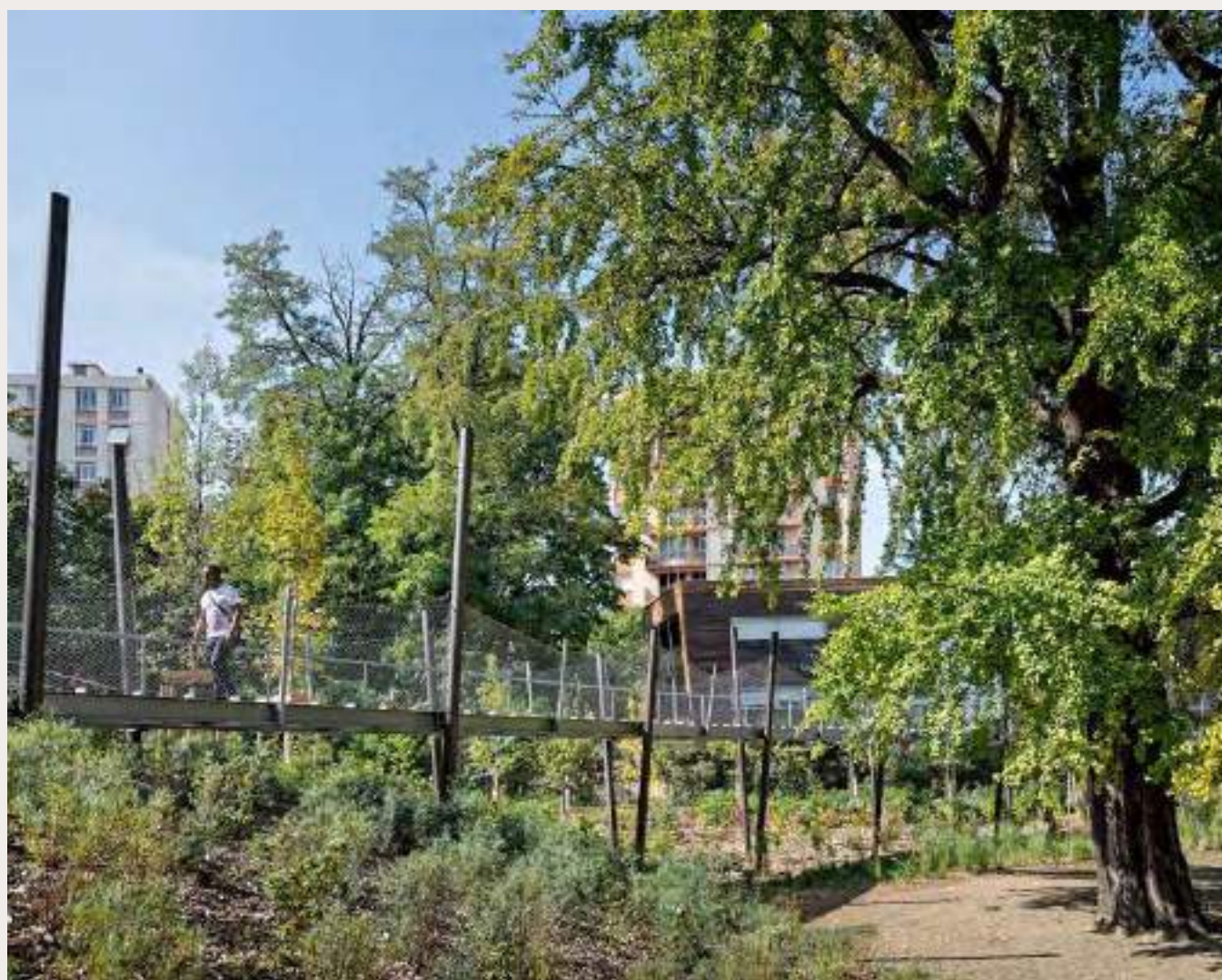
Passerelle du parc Jacob-Hugentobler, Villeurbanne (69).
