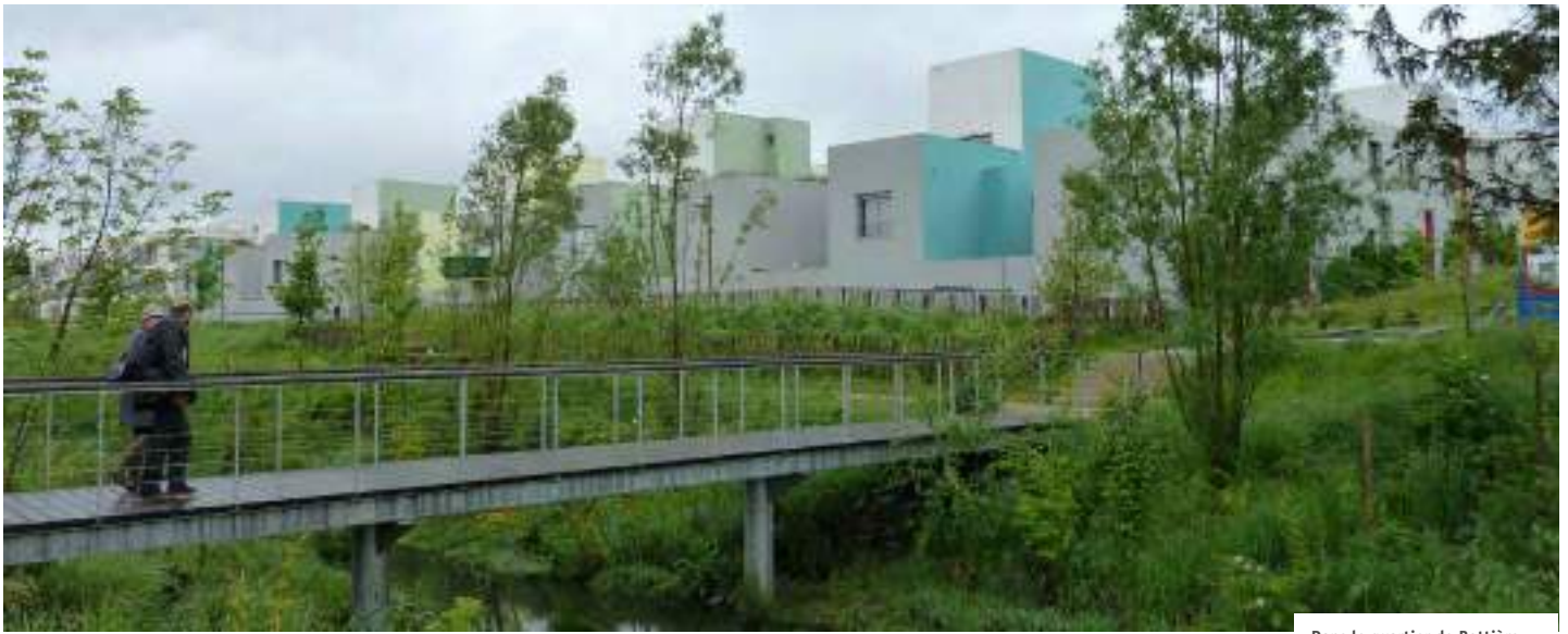
Dans le quartier de Bottière Chénaie à Nantes (44), le ruisseau des Gohards a été réouvert et les eaux pluviales collectées dans des fossés et des bassins. Concepteurs: Atelier de paysage Bruel et Delmar. © Sandrine Larramendy, P&C
