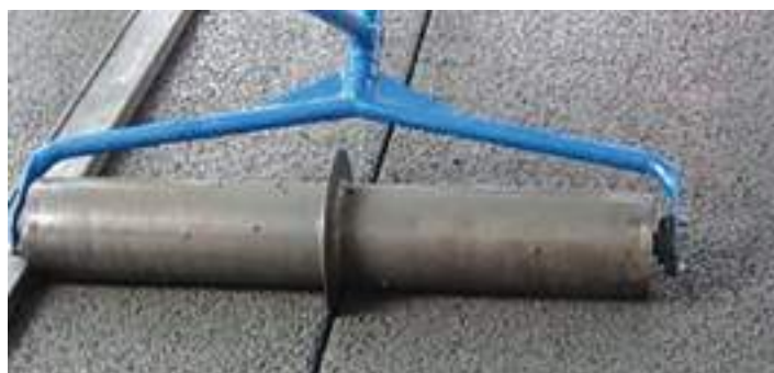
Coulage et réglage à l'aide d'un roller-striker (© CIMBETON référence Guide T69)
