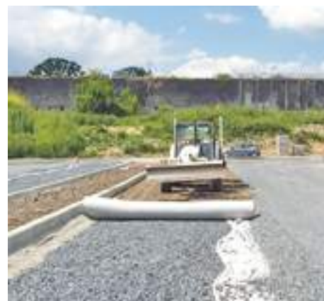
Pose d'un géotextile (© O2D, Esplanade du Champ de Mars - Lille)
