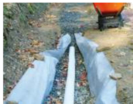
Pose d'un drain pour faciliter les écoulements (© Ecohabitation)
