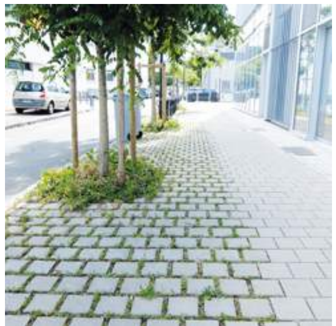
Exemple de pavés à joints engazonnés - Nantes (©P&C – Sandrine Larramendy)
