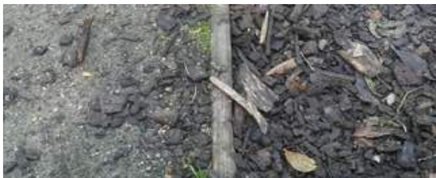
Exemple de bordure en bois remplissant correctement son rôle pour séparer un revêtement organique d'un enrobé (© P&C – Robin Dagois)
