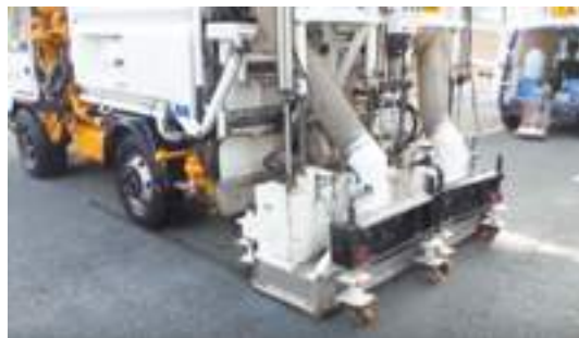
Décolmatage par pression/aspiration (© Sotraveer)
