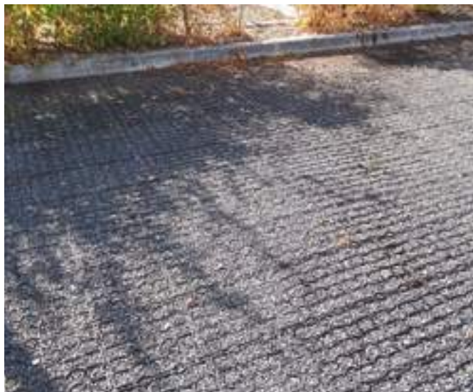
Association de dalles PVC alvéolées avec un remplissage gravier (© Wendy Arnould, Pole Dream)
