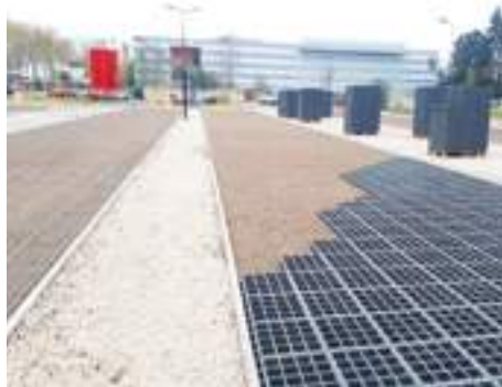
Pose de dalles alvéolées (© Wendy Arnould, Orléans)
