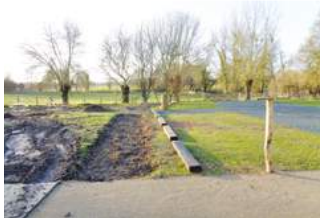
Mise en œuvre d'un parking perméable en mélange terre-pierre (© Sylvie Pigot – Ecce Terra)
