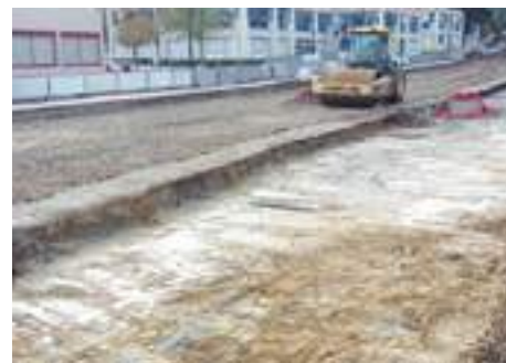
Exemple de terrassement d'une zone accueillant un revêtement perméable (© P&C – Robin Dagois)
