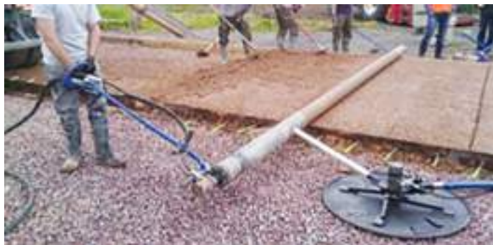
Coulage et réglage à l'aide d'un roller-striker (© CIMBETON référence Guide T69)
