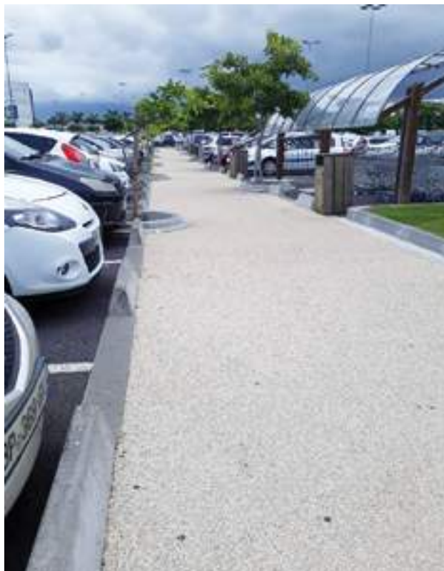
Béton drainant pour voie piétonne (© Wendy Arnould – Saint Pierre)
