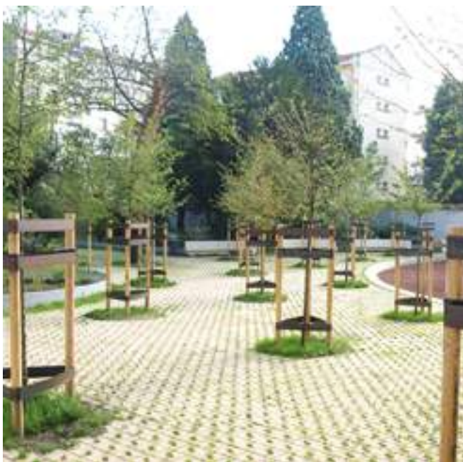
Exemple de pavés à ouverture de drainage - Villeurbanne, Parc Édouard Glissant (© VAL'HOR)
