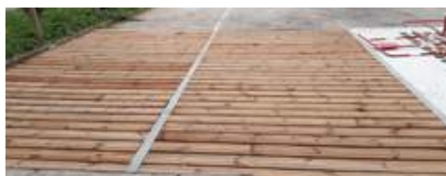
Exemple de platelage pour places de stationnement (© Wendy Arnould)
