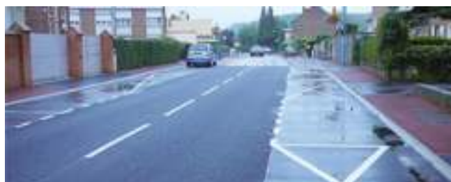
Enrobé poreux utilisé en voirie à Douais (© Hérin - Adopta)
