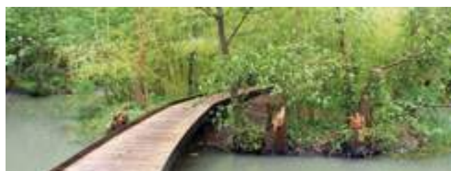
Exemple de platelage avec présence de chasse-roues (© Agence TALPA)
