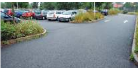
Enrobé poreux sur structure réservoir (© Lille Métropole)
