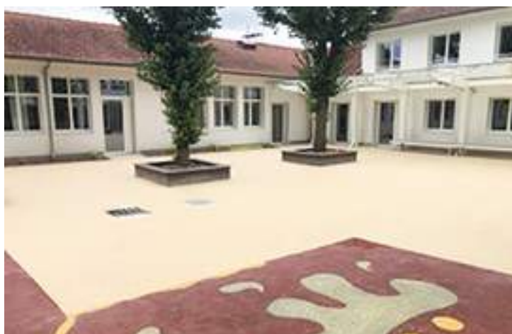
Utilisation d'un béton de résine dans une cours d'école (© Anthély - Meudon)
