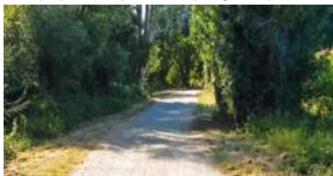
Exemple de revêtement minéral perméable pour voie cyclable (© P&C - Robin Dagois)
