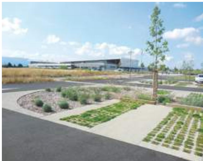
Certains revêtements alvéolés peuvent être aussi des solutions directement coulées sur place (© Viasols)
