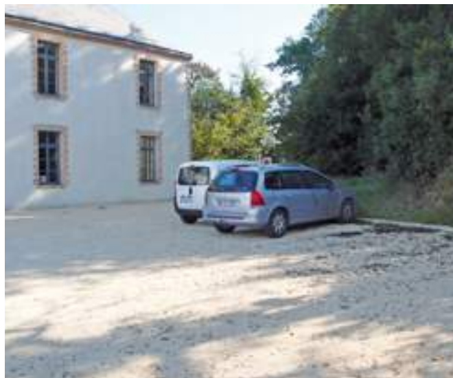
Exemple de parking perméable en graviers (© Sylvie Pigot – Ecce Terra)
