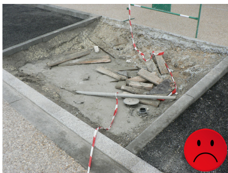
Photo 13 : Les fosses de plantation ne doivent pas servir de poubelle ou de stockage et ne doivent pas être polluées.
