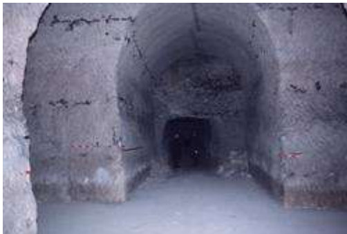
Les anciennes carrières souterraines de craie de Meudon © BRGM - François Michel
