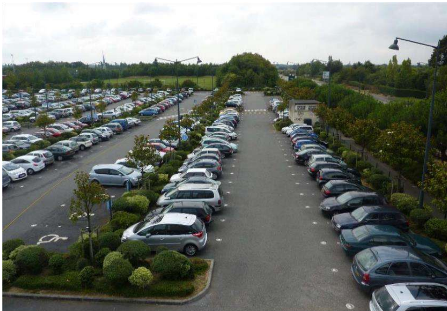
Le parking drainant du relais du métro La Poterie
