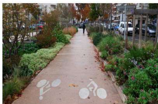
APRÈS - Aujourd'hui, un quart de l'emprise entre les bâtiments a retrouvé des sols vivants. Les noues sont installées sur un mélange terre/pierre drainant, tout comme la piste cyclable, l'eau communiquant entre les noues et pouvant alors circuler et s'infiltrer sous la piste.
