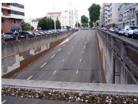
AVANT - A Lyon, les anciens tunnels qui permettaient de passer sous les carrefours ont été recouverts et transformés en grands bassins souterrains de récupération. En cas de trop plein, l'eau des noues s'évacue vers ces bassins, et sert ensuite à l'arrosage des espaces verts et au nettoyage des voiries.
