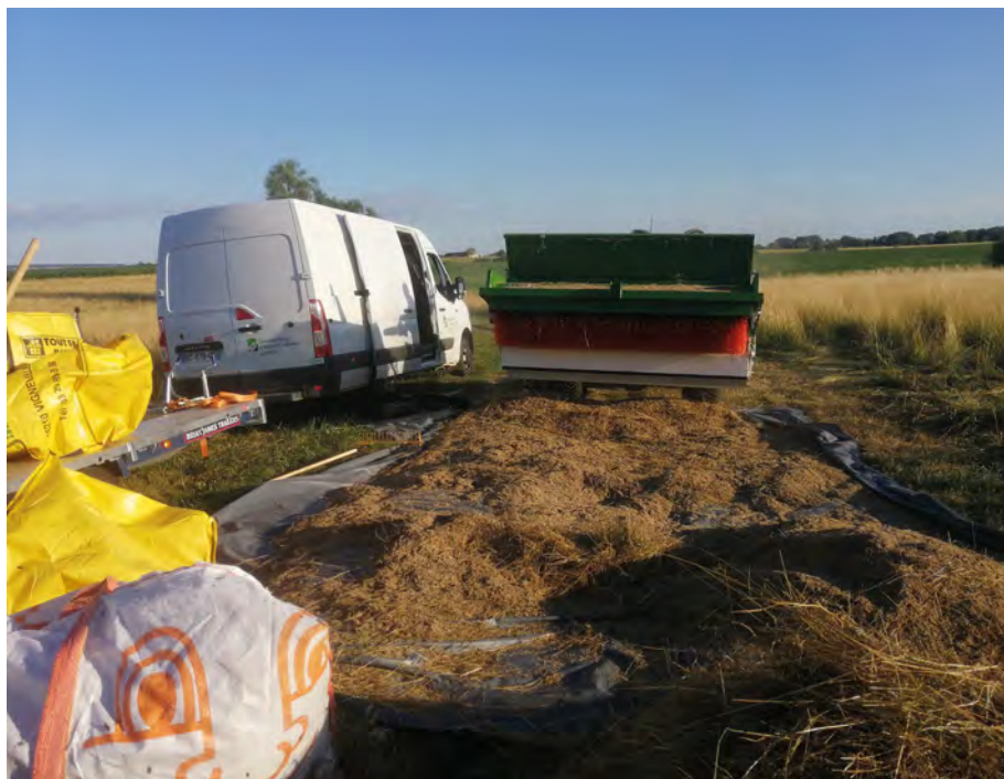
Déchargement d'une brosseuse** tractée
