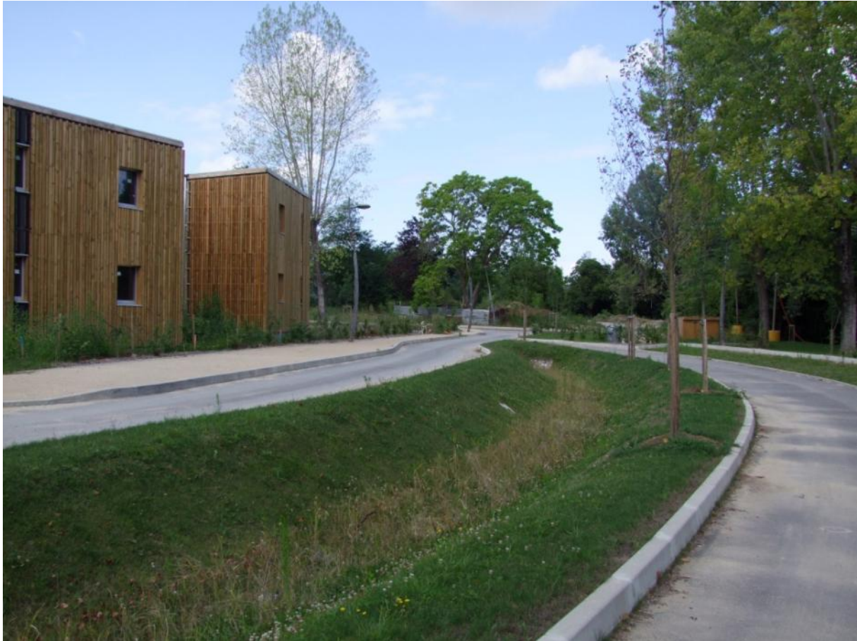
Gestion des eaux pluviales par noues végétales, écoquartier Le Séqué.
