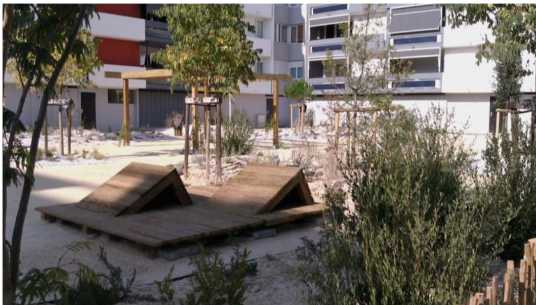
La cour commune de la résidence après les travaux
