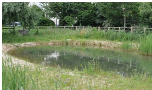
Pièce d'eau collectant les eaux provenant de la noue. / Maxime Dépino, Plante & Cité
