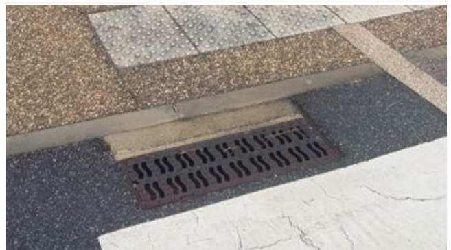
Grille permettant de capter les eaux de pluie du parking et de les canaliser vers la noue. / Robin Dagois, Plante & Cité
