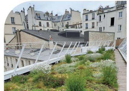
Un **système de végétalisation de toiture** est un ensemble de matériaux et de végétaux mis en place sur une toiture ou une terrasse avec l'objectif d'assurer la pérennité de la végétation comme de la construction. Il comprend deux éléments principaux :
