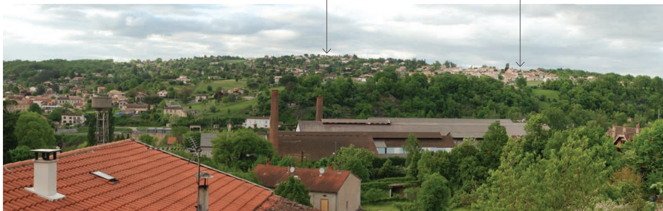
2.259-261 - La présence du végétal permet d'adoucir l'urbanisation éclatée des coteaux d'Arthès : ici la différence se lit entre des pentes urbanisées jardinées et une urbanisation plus minérale.
