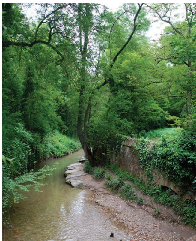
Le ruisseau de Causse a fait l'objet d'un aménagement de chemin piétonnier sur 4 km jusqu'en coeur de ville d'Albi : c'est l'Echappée Verte
