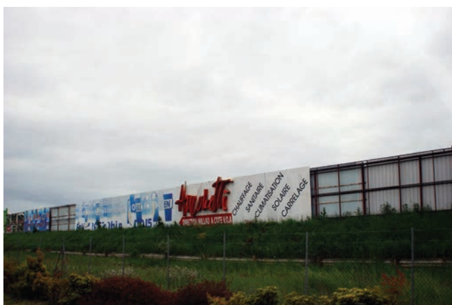
Les clôtures publicitaires du circuit du Séquestre : peu avenantes pour l'entrée de ville par la RN 88
