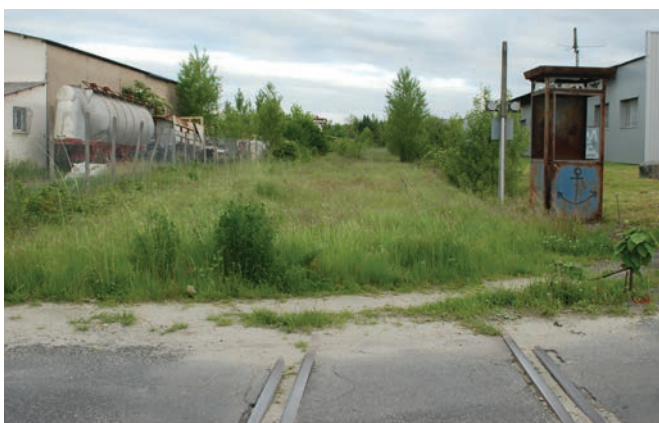
Ancienne voie ferrée ici dans la ZI Saint-Antoine/Albi est - Saint-Juéry
