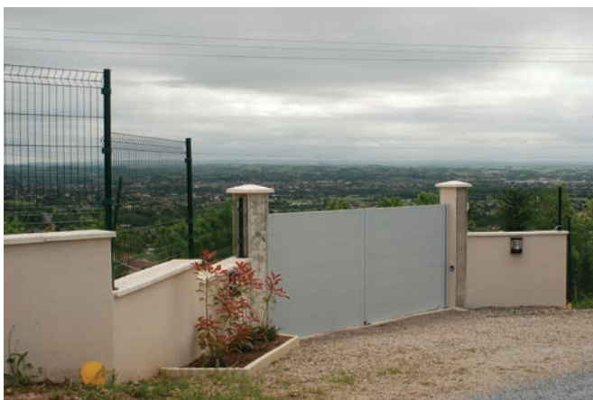
Des aménagements privés (ici des clôtures) qui bloquent les vues et banalisent le paysage parcouru au fil de la petite route des coteaux du Tarn
