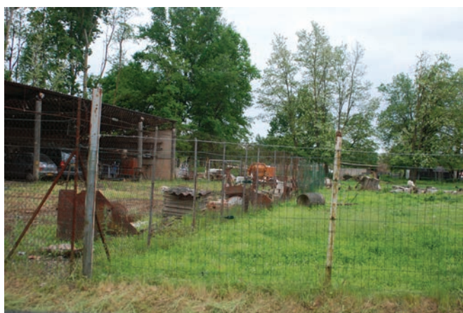
Le fond de la boucle de Canavières, à réhabiliter
