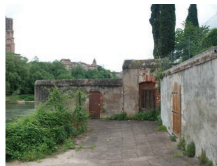
Blocage des promenades par des emprises privées en bord de Tarn rive droite, Albi
