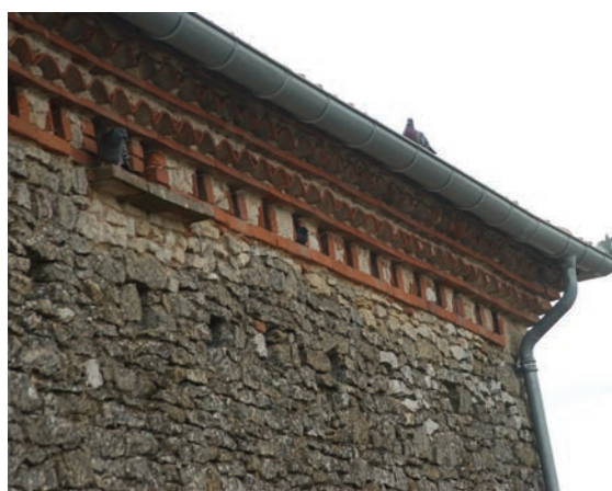
Détail d'association de calcaire et de brique sur un bâtiment du centre village de Rouffiac
