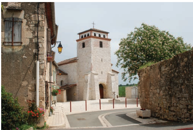
Exemple de réhabilitation architecturale et paysagère, centre-village de Labastide-Dénat
