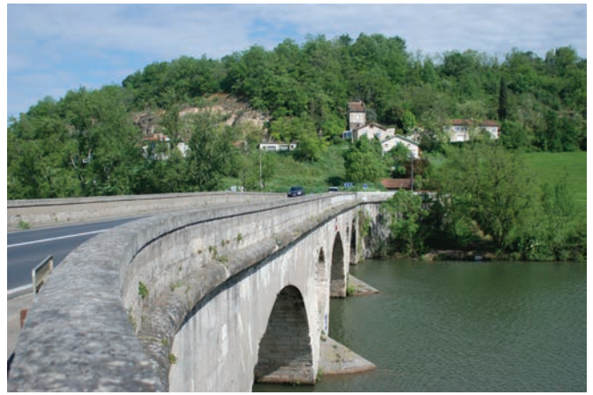
Le pont de Marssac-sur-Tarn un des cinq ponts routiers de la Communauté d'agglomération
