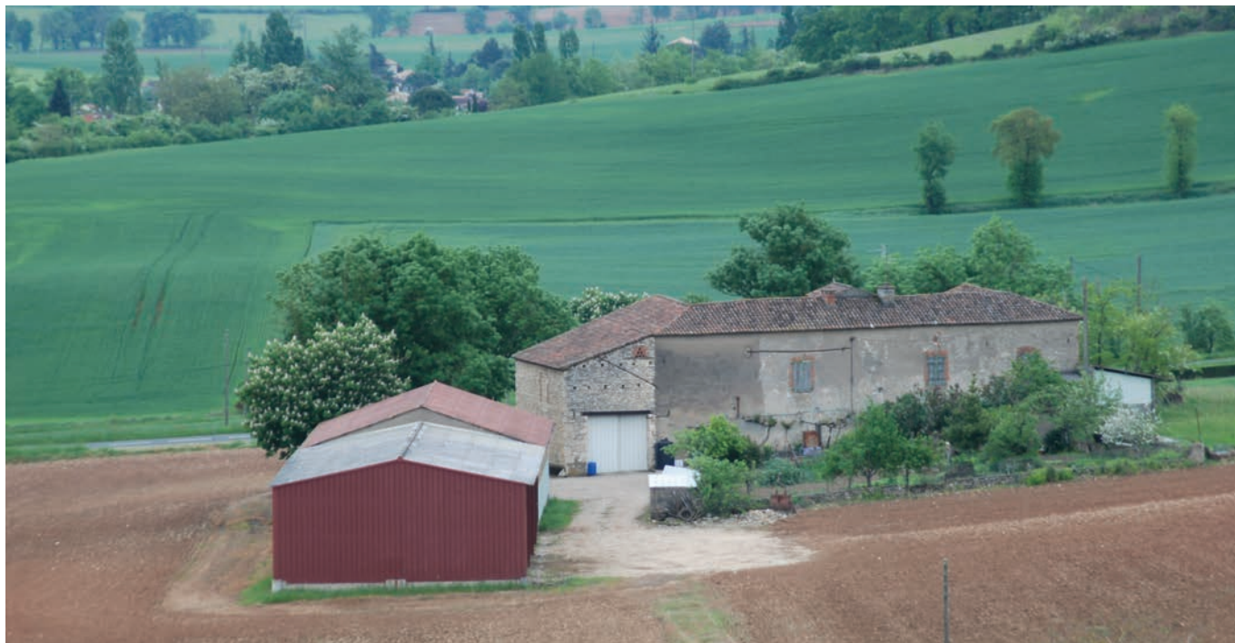
Un nouveau bâtiment agricole correctement inscrit dans le paysage grâce au choix d'implantation, à la volumétrie choisie, ainsi qu'à la teinte retenue pour le revêtement de façade faisant écho à la couleur de la terre (vers Puygouzon)
