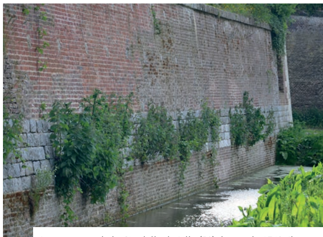
Les remparts de la Citadelle de Lille (59) datent de 1763. Ils sont réalisés en brique avec un soubassement en grès dur. Ils abritent une flore et une faune intéressante. I © Ville de Lille
