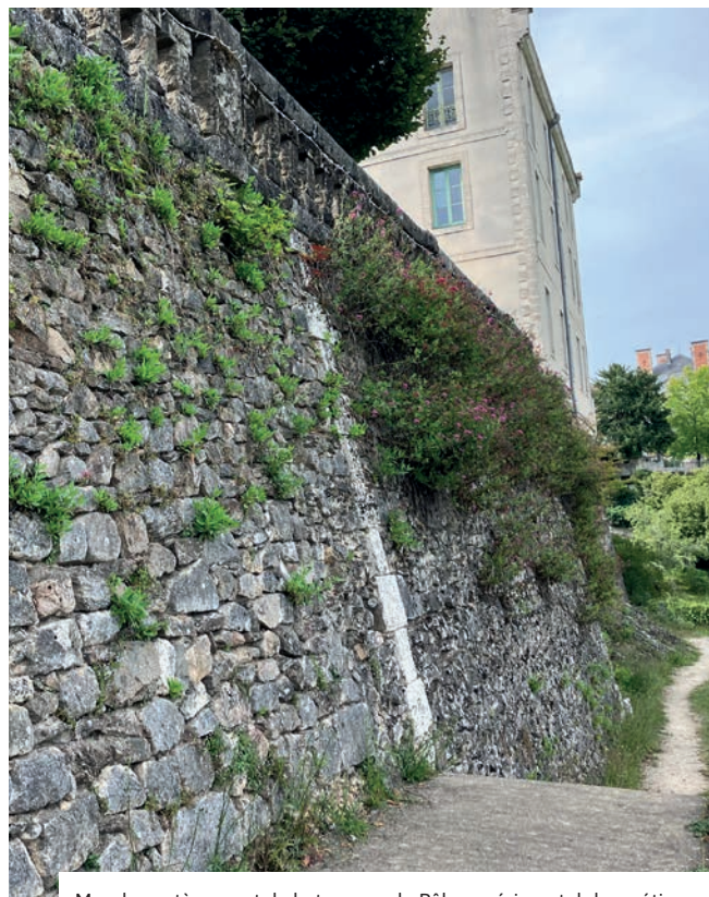
Mur de soutènement de la terrasse du Pôle expérimental des métiers d'arts de Nontron (24). Les nombreux murs de cette petite ville de Dordogne sont en pierres calcaires maçonnés. I © Sandrine LARRAMENDY
