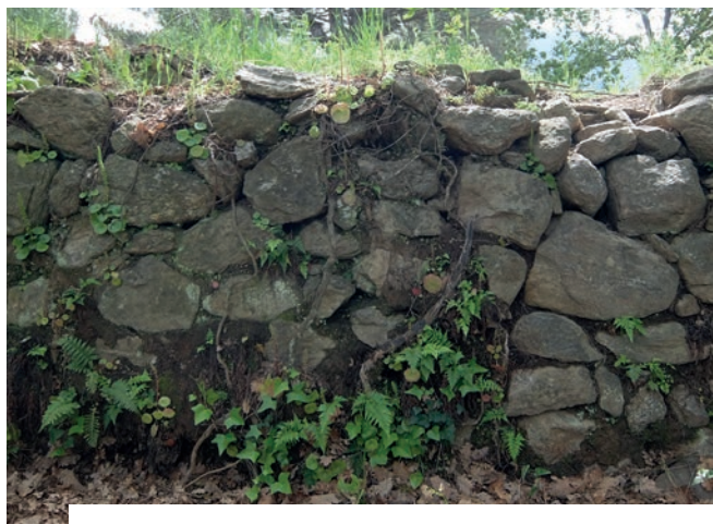
Au fil du temps et des dépôts aériens, les interstices se remplissent de terre. Muret de soutènement en limite de champs à Laroque des Albères (66). I © Sandrine LARRAMENDY
