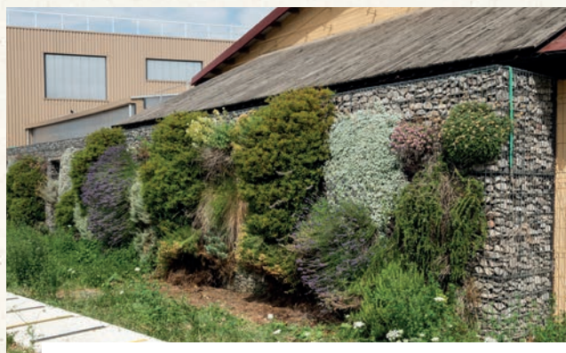
Le gabion en parement de la façade de l'atelier technique de la gare de triage SNCF de Villeneuve-Saint-George (94). I © Alexandre PETZOLD
