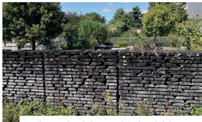
Mur d'enceinte du jardin botanique de Bordeaux (33). Il est constitué d'un empilement de planches de bois brutes. Conçues par : Catherine MOSBACH, paysagiste DPLG urbaniste et Françoise-Hélène JOURDA, architecte. I © Marc BARRA
