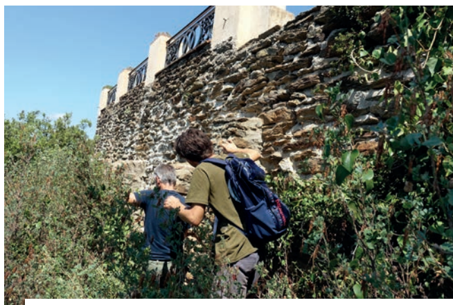
La terrasse du Rayolet est située en surplomb sur la Méditerranée. Le mur de soutènement en pierres maçonnées présente des traces de rejointoiement assez récents. | © Domaine du Rayol et Sandrine Larramendy
