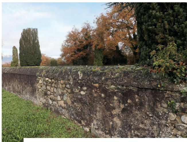
Autre exemple de mur crépi qui accueille des plantes au fil du temps : un long mur de séparation entre un cimetière et des champs à Laconnex (Suisse). Ici le crépis tombe un peu laissant apparaître les pierres. | © Hélène BURGISSER HINDEN.
