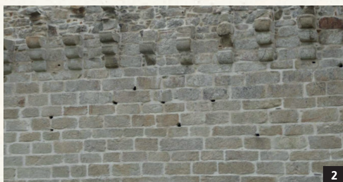
1 - Photographie repérant les nids de martinets existants avant les travaux. 2 - Photographie après les travaux avec maintien des cavités existantes. I © LPO44
