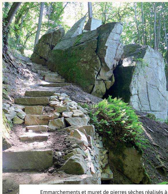
Emmarchements et muret de pierres sèches réalisés à l'occasion du projet par des artisans muraillers. | © Atelier CAP
