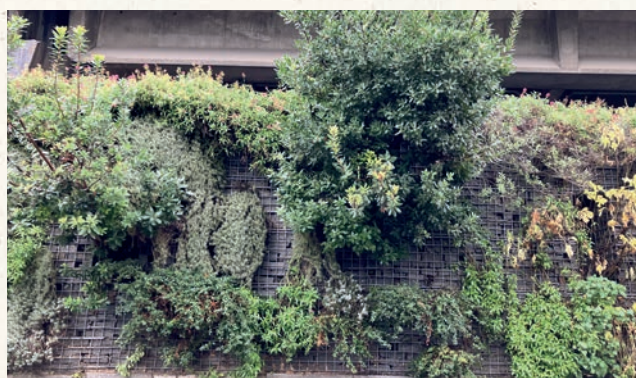
Mur en gabion de la rue d'Oradour-sur-Glane à Paris (75), au moment de sa construction en 2008 et avant installation des végétaux. I © Google - Le même gabion en 2024, la végétation s'est bien implantée et recouvre par endroit le gabion. I © Sandrine LARRAMENDY
