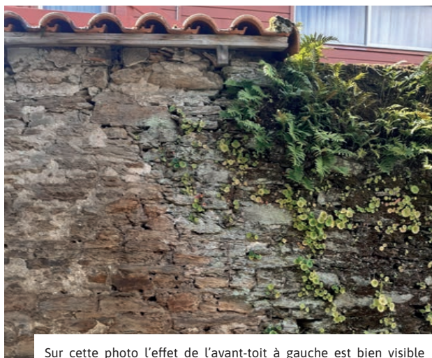
Sur cette photo l'effet de l'avant-toit à gauche est bien visible avec une végétation nettement moins développée quand il existe. I © Sandrine LARRAMENDY
