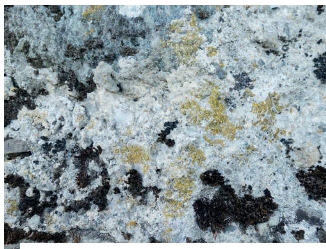
La rugosité de la surface des pierres est favorable au développement des mousses et des lichens. Mur de la Perle du Lac à Genève (Suisse). I © Sandrine LARRAMENDY
