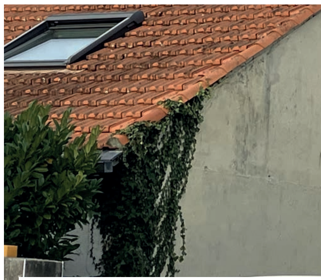
Ce lierre a atteint la gouttière et menace la toiture, il doit être enlevé pour préserver la toiture. I © Sandrine LARRAMENDY
