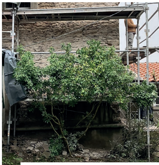
Chantier de ravalement de façade avec un enduit à la chaux avec conservation d'un arbuste existant (Oranger du Mexique) malgré l'échafaudage. I © Sandrine LARRAMENDY
