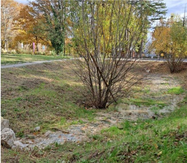
Récolte des eaux pluviales des chemins dans une noue sous forme de dépression du terrain
