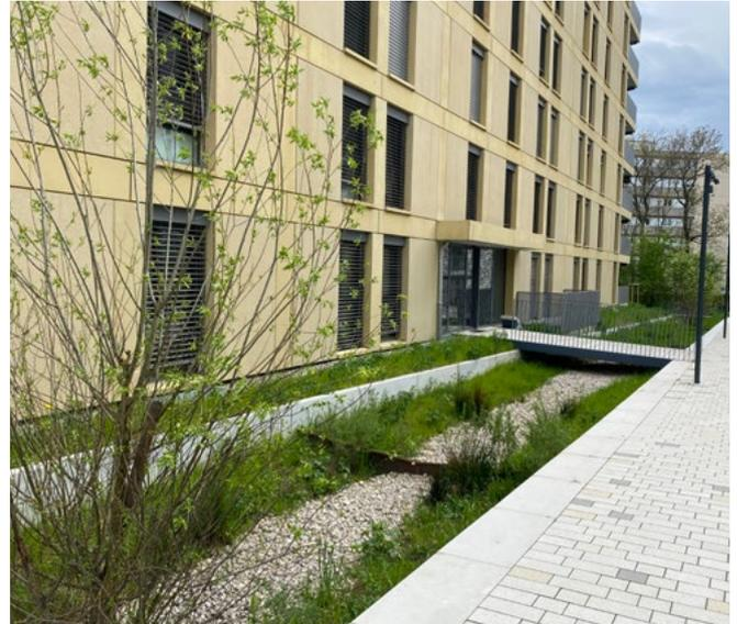
Récolte des eaux pluviales des chemins dans une noue sous forme d'ouvrage construit
