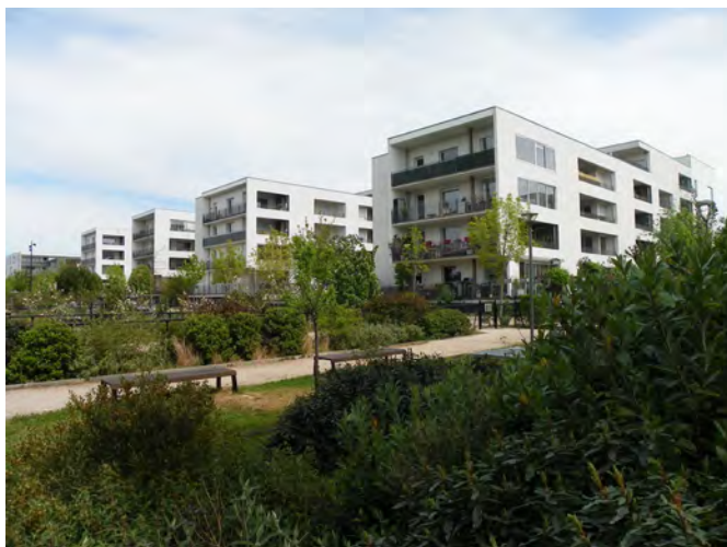
Photo 1 : Relevés de terrain, quartier Vidailhan, Balma.
