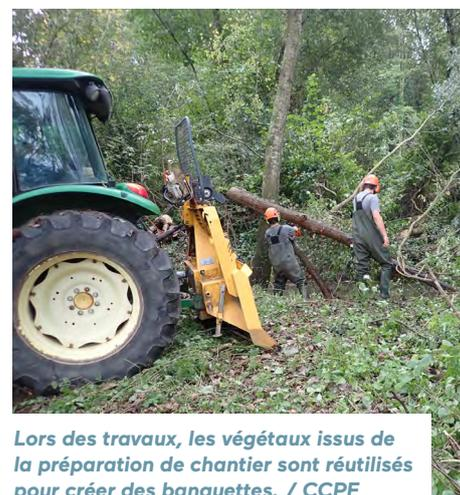
Lors des travaux, les végétaux issus de la préparation de chantier sont réutilisés pour créer des banquettes. / CCPF
