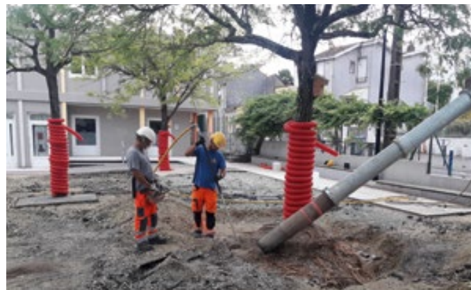
Travaux de retrait des enrobés et de leurs fondations avec une aspiratrice.
