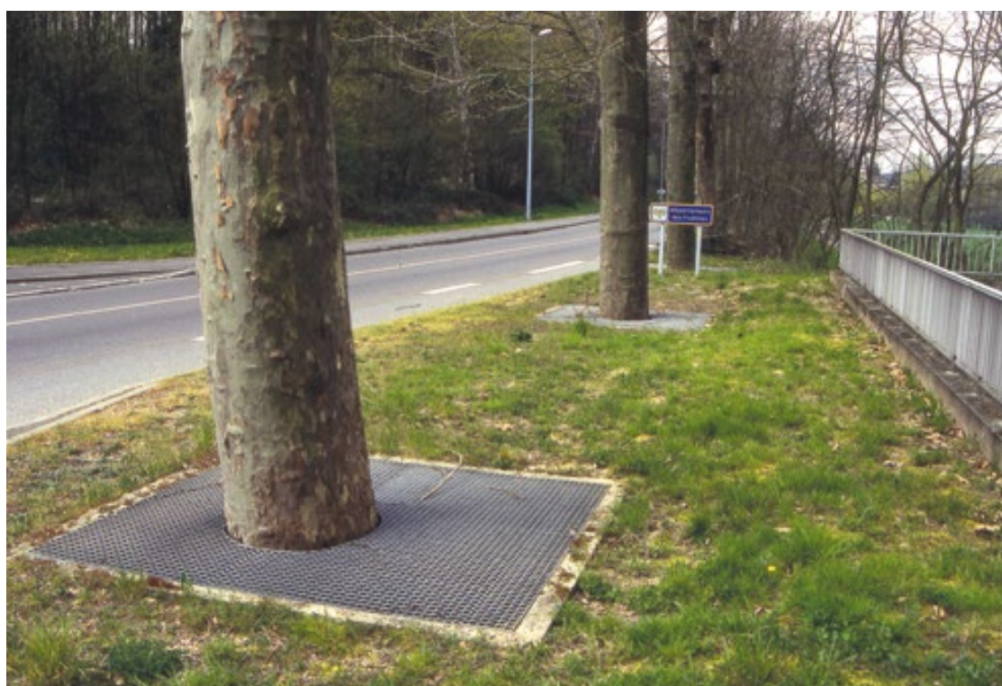
Fermeture autour de l'arbre au moyen d'un caillebotis métallique porté par un cadre en béton, dans un accotement routier, consécutivement au réaménagement de la voirie. Bièvres (91), 1995
