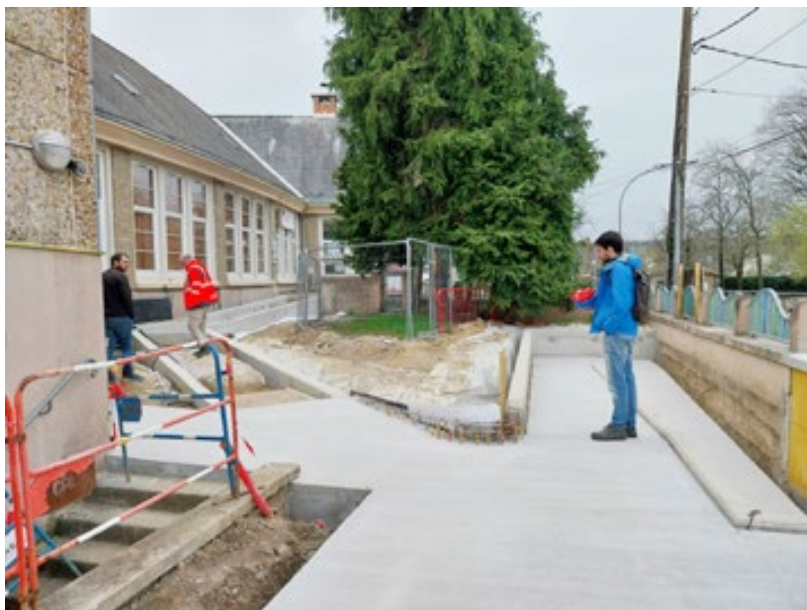
Le chantier en cours. Mars 2025
