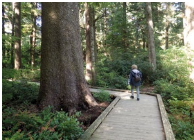
Cheminement en bois construit au-dessus du sol pour éviter le piétinement et le recouvrement du sol. Orégon (États-Unis)
