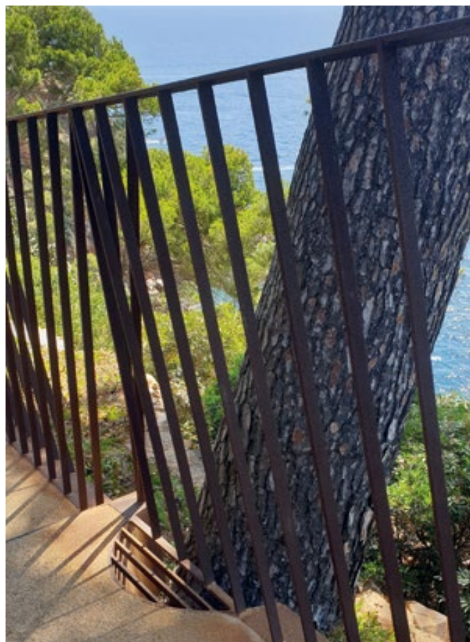
L'allée a évité le pin et le matériau dur a été remplacé ponctuellement par une grille. Jardin botanique du Cap Roig, Espagne, 2024
