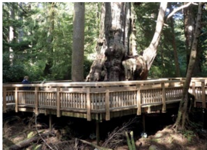
Cheminement en bois construit au-dessus du sol pour éviter le piétinement et le recouvrement du sol. Orégon (États-Unis)
