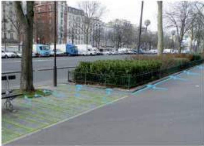
Gestion de l'écoulement de l'eau de la voirie vers les espaces perméables (Cours de Vincennes, Paris 12 e ).
