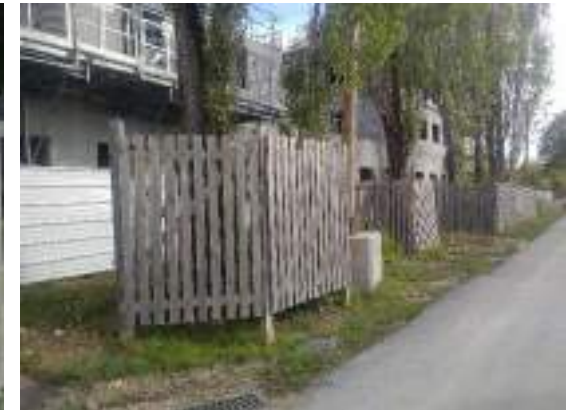
Exemples de protection d'arbres remarquables et de mise en défens de zones à enjeux écologiques en phase chantier
