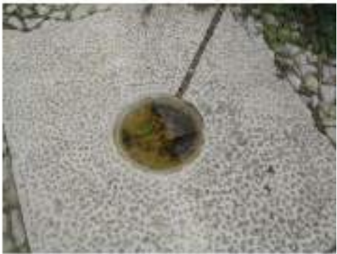
Micro-point d'eau avec trop-plein relié aux espaces végétalisés à proximité – Jardin de l'Arche, La Défense
