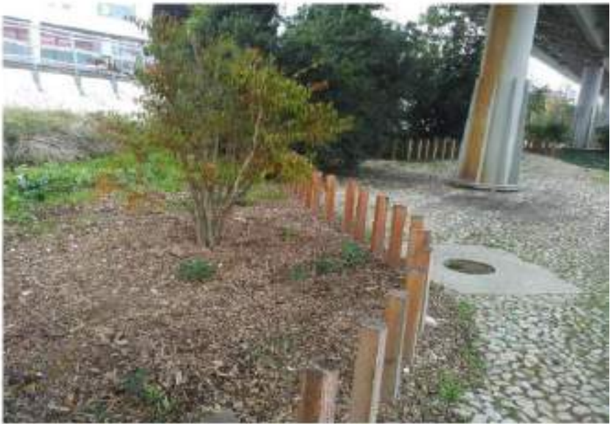
Micro-point d'eau avec trop-plein relié aux espaces végétalisés à proximité – Jardin de l'Arche, La Défense
