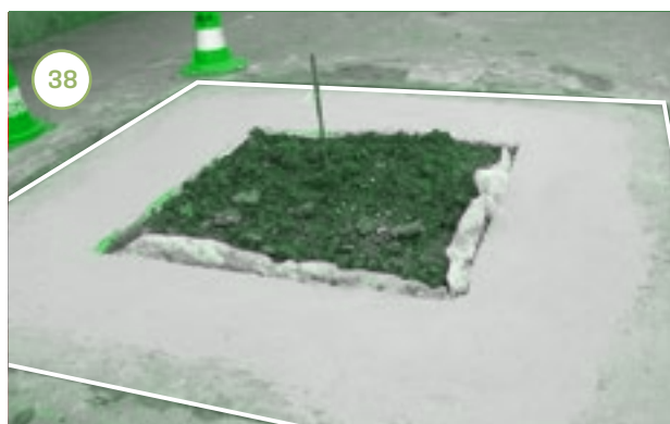
Fig. 37 et 38. Mise en œuvre de dalle de répartition
