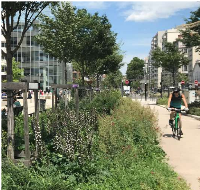
Rue Garibaldi à Lyon (69) : fosse continue avec plusieurs strates de végétation. Conception : Atelier A/S Marguerit, Passagers des Villes, LEA, Artelia, Siétudes, SOBERCO Environnement, ETC, Atelier d'Écologie Urbaine. © Atelier A/S Marguerit
