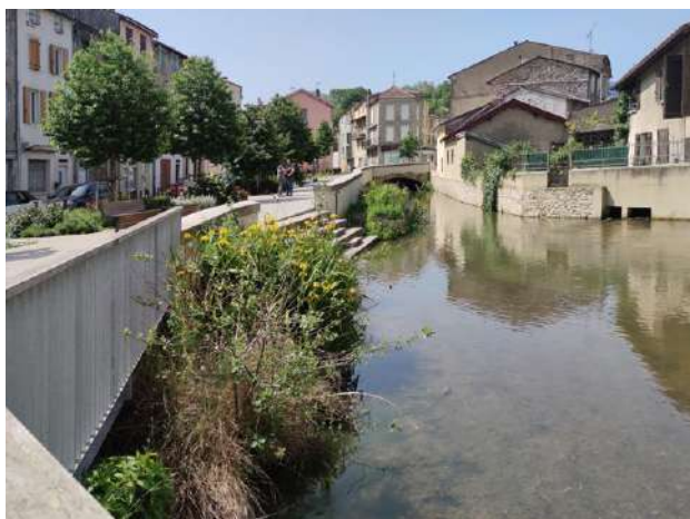
Requalification du quartier de Secoustous et découverte de la rivière Pipié (Trame bleue) en cœur de ville de Lavelanet (09). MOE : Architecture et Paysage
