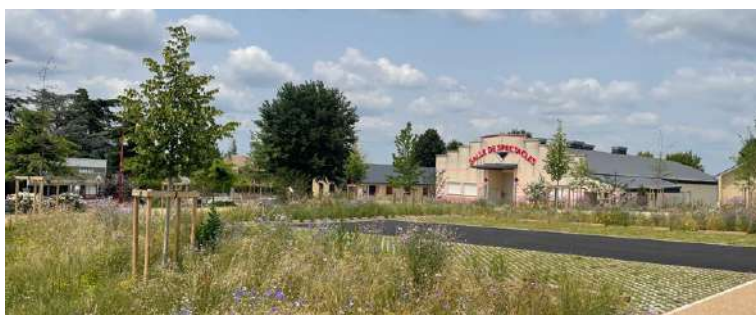
Place François-Fabré à Réquista (12) : Requalification avec 100 % de revêtements perméables (prairie, chemins en stabilisé, dalles alvéolaires végétalisées, mélange terre-pierre, enrobé drainant).
