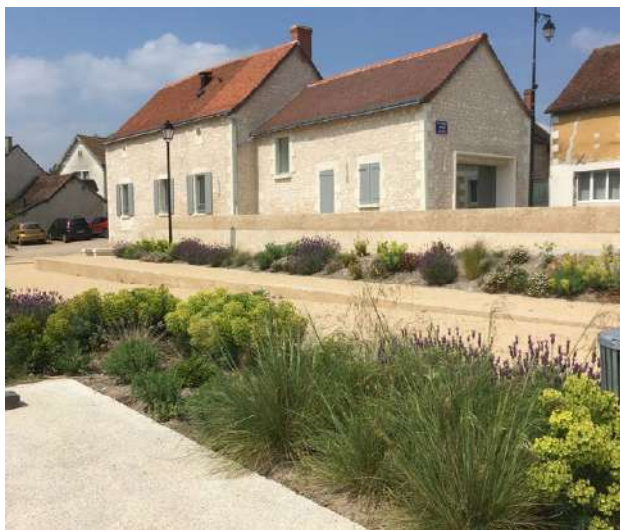
Cœur de village d'Antogny-le-Tillac (37) réalisé en béton de site* . MOE : © Bauchet & de La Bouvrie architectes, De Long en Large paysagistes.
