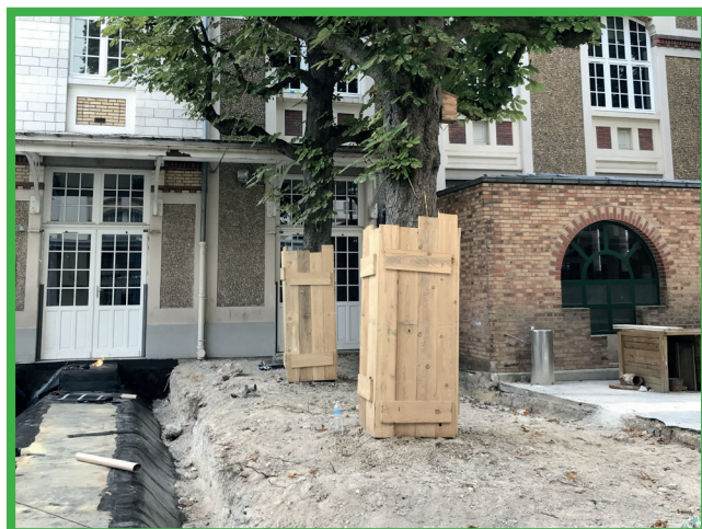
Protection inadaptée Planches en bois apposé directement sur le tronc
