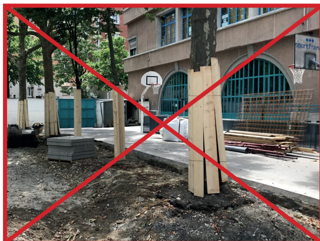
Protection inadaptée Planches en bois apposé directement sur le tronc
