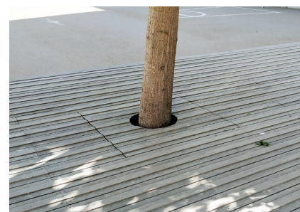
Platelage bois avec trappe de visite escamotable Cour Oasis EE Alain Fournier, 14 e arr.
