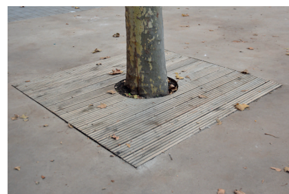
Platelage bois au niveau fini (asphalte) Cour Oasis Coll. Queneau, 5 e arr.
