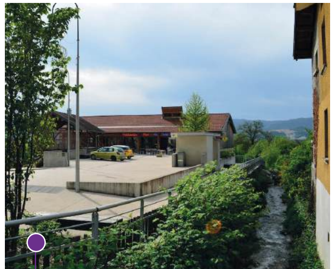
La place centrale le long de la rivière et le bassin d'orage Source : site internet de la commune de La Rivière
