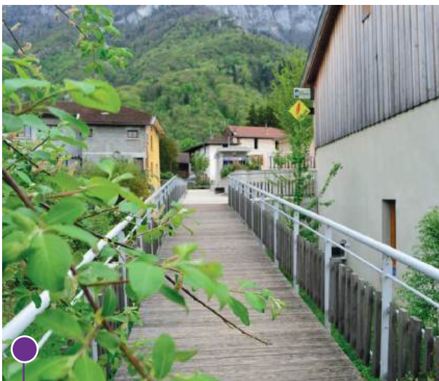
La passerelle sur la commune de La Rivière Source : DREAL Aura, 2017
