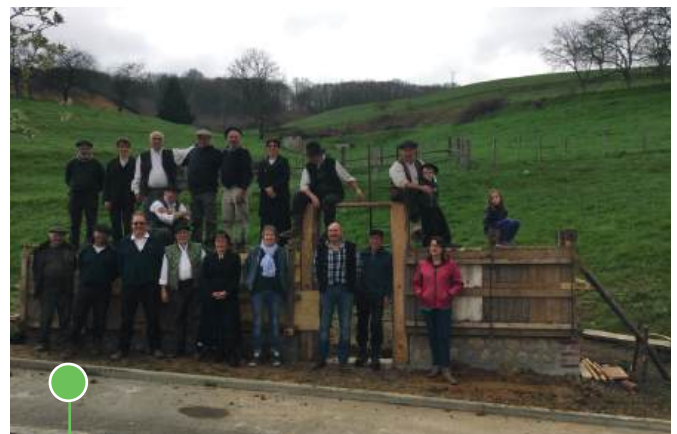
Construction du muret - source : Brion
