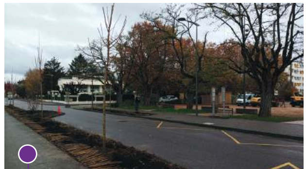
Désimperméabilisation des pieds d'arbres, place du Champ de Foire Source : Belleville-en-Beaujolais, 2022
