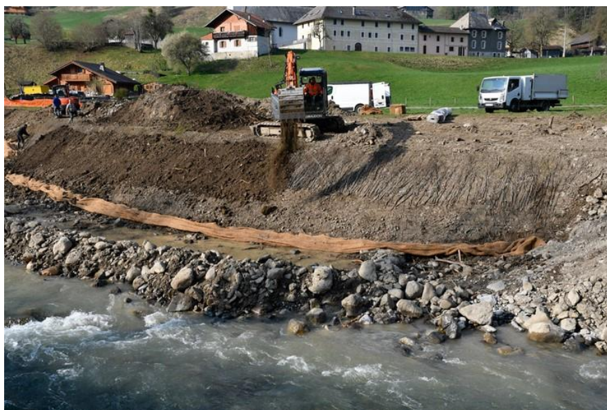
Figure 18 : Couche de branches à rejets utilisée sur un talus en berge de rivière. Les branches sont positionnées les unes à côté des autres, elles sont recouvertes d'une très fine couche de terre puis d'un géotextile © S. De Danieli.
