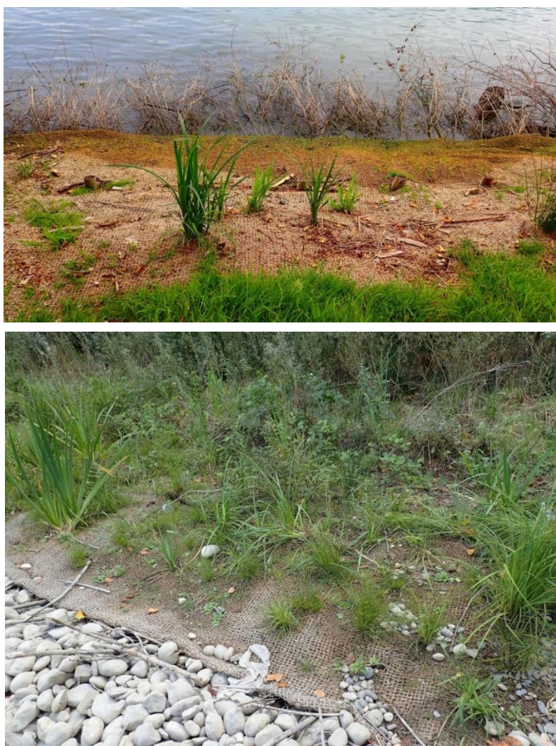
Figure 7: Banquette d'héliophytes à la mise en place et après une saison de végétation © A. Evette.
