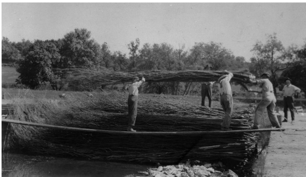
Figure 2: Matelas de saule - Un groupe de travailleurs du département d'ingénierie des États-Unis déplaçant des nattes de saule dans la rivière ; celles-ci étaient la base des barrages en ailes sur le fleuve Mississippi, vers 1920, University of Wisconsin-La Crosse, Murphy Library, Special Collections.
