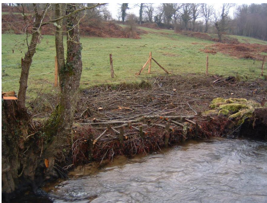
Figure 28 : Treillis de branche en bord de rivière ©D. Jaymond.
