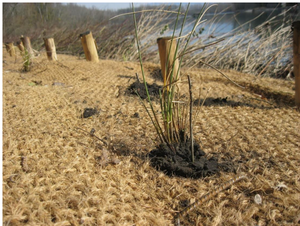
Figure 6 : Plantation d'hélophytes sous un géotextile en berge de rivière © S. De Danieli.
