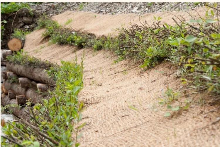
Figure 22 : Lits de plants et plançons avec boudins de géotextile au-dessus d'un caisson végétalisé © S. De Danieli
