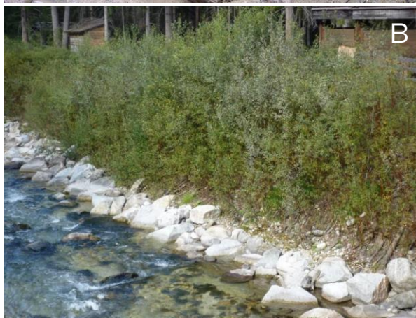
Figure 17 : Couche de branches à rejets à San Martino in Badia (Italie) (A) à la mise en place en 2006, (B) en 2008 et (C) son évolution en 2024 © G. Pederoa, A. Evette et J. Rousset.
