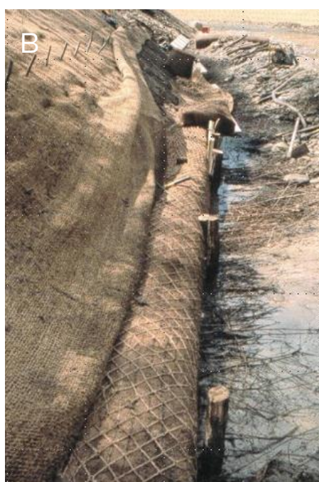
Figure 13: Etapes successives de mise en œuvre d'une fascine d'héliophytes en pied de berge. © A. Evette
