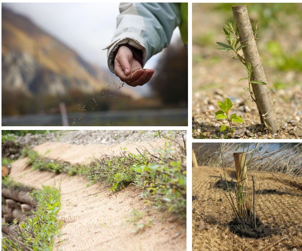
Figure 3 : Exemples de parties végétales servant d'éléments structurants pour des aménagements de protection (graines, boutures, plançons ou plante entière) © N. Daumergue et S. De Danieli.
