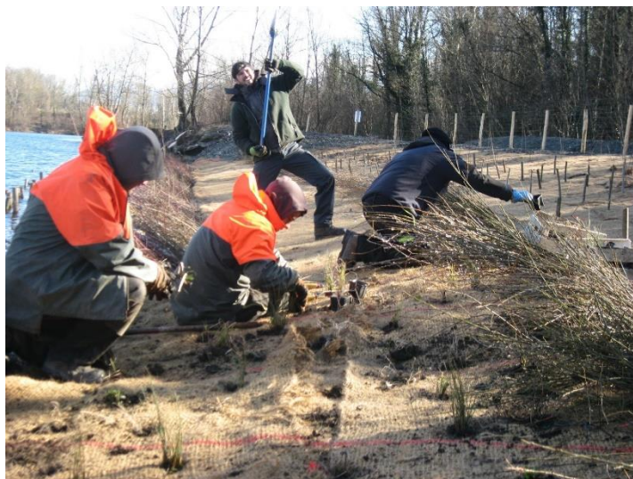
Figure 10: Travaux de plantation d'héliophytes sur une berge renforcée par un géotextile biodégradable, suivant les différentes étapes de mise en place depuis la préparation du trou, jusqu'au tassement du sol après plantation. © Grenoble Alpes Métropole.
